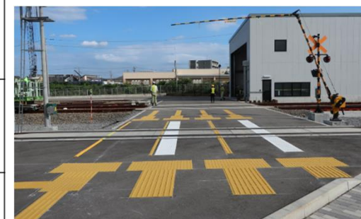
本実験の誘導表示等の敷設状況
