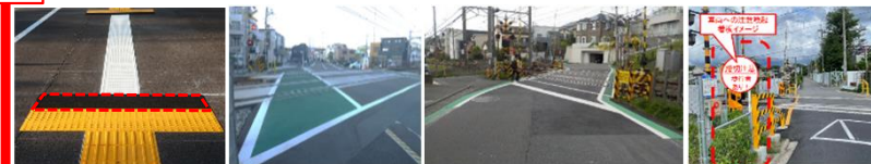
ゴムチップ舗装 カラー舗装 踏切道内の車道外側線 注意喚起看板
