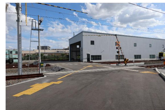
最終確認実験の 誘導表示等の敷設状況
