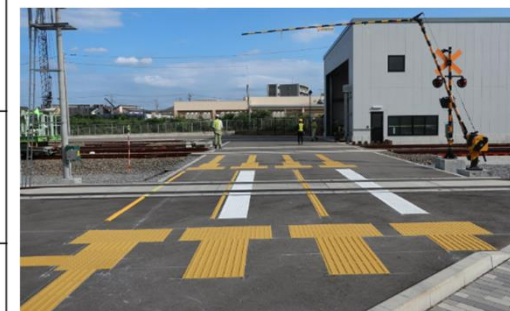
本実験の誘導表示等の敷設状況
