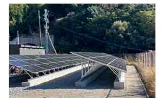
太陽光発電施設の設置
