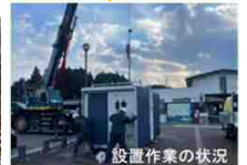
設置作業の状況
