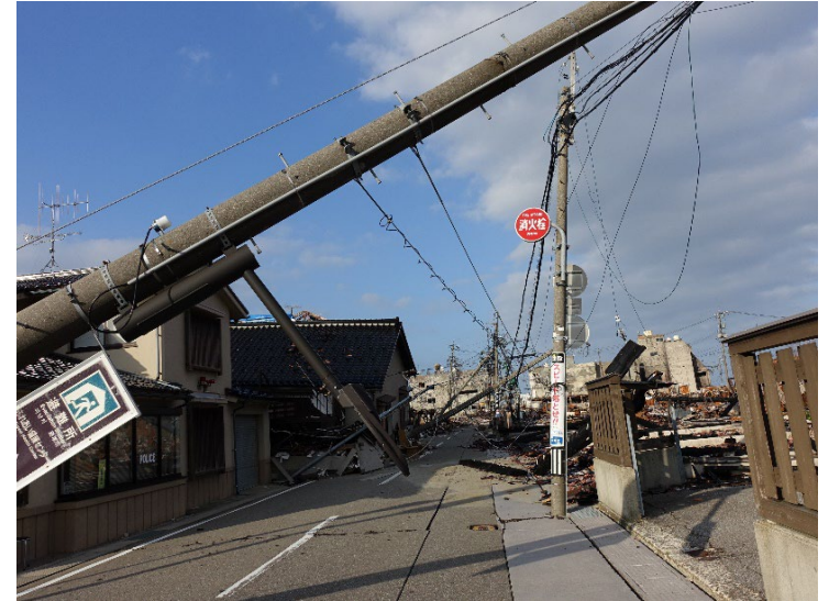
能登半島地震により倒壊した電柱
