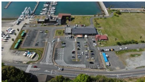
熊本県宇土市 道の駅「宇土マリーナ」
