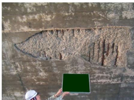
補修前(剥離・鉄筋露出)
