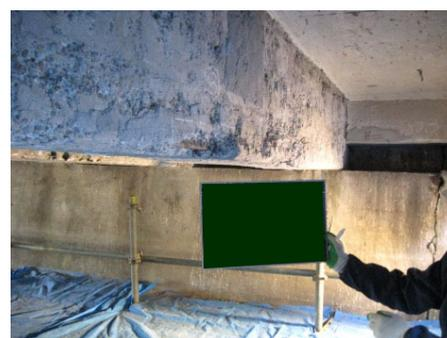
補修前(剥離・鉄筋露出)
