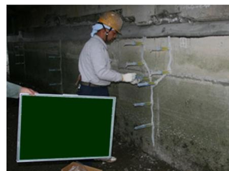
補修状況(ひび割れ注入)
