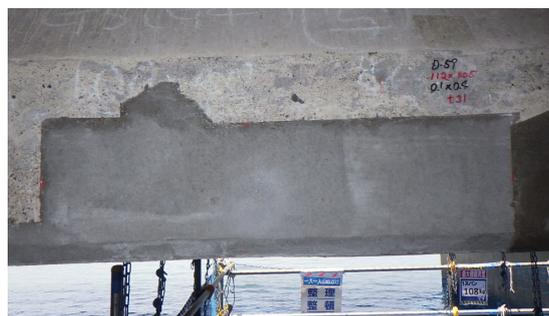
【剥離・鉄筋露出】
