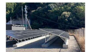
太陽光発電施設の設置
