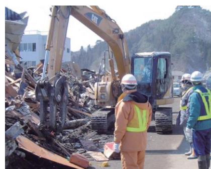
図 24 地域の建設業者による道路啓開
