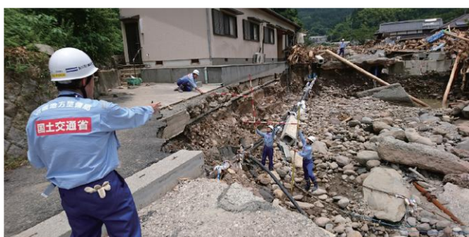
図 23 公共土木施設の被災状況調査
