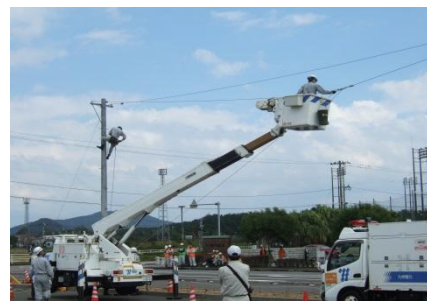
占有者（電力会社）によるケーブル敷設
