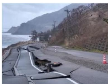
国道249号の道路亀裂
