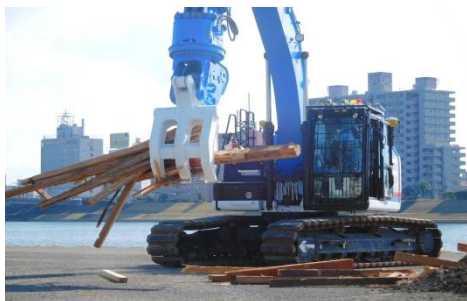
遠隔操作によるガレキ等撤去
