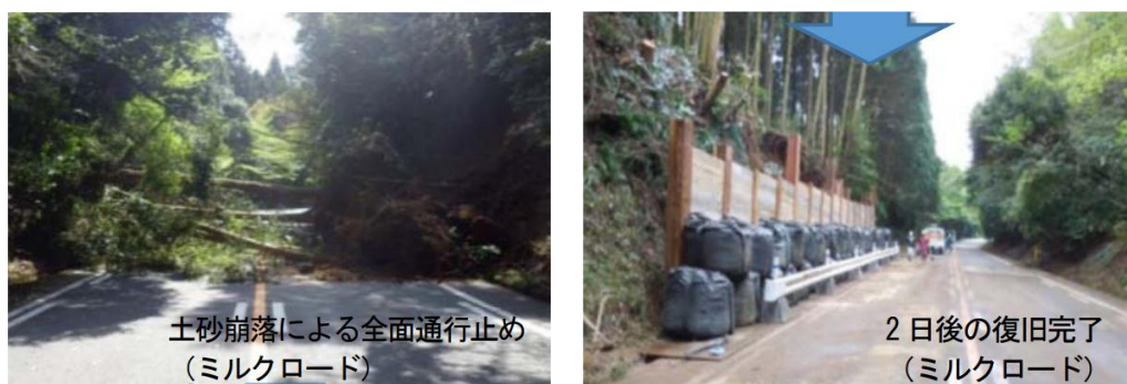
図 21 熊本地震における道路啓開作業
