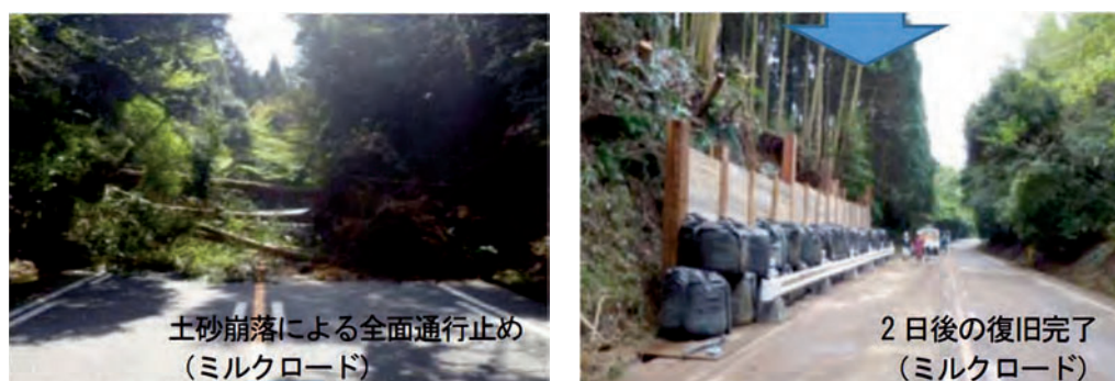
図 21 熊本地震における道路啓開作業
