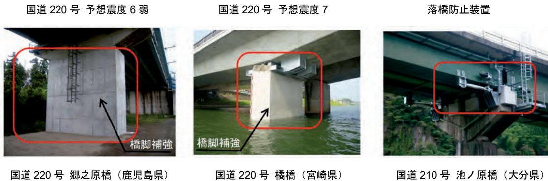
図 34 九州内における耐震補強状況
