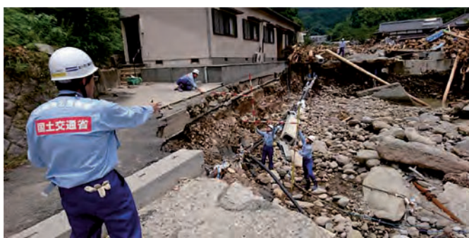
図 23 公共土木施設の被災状況調査
