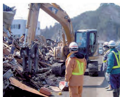
図 24 地域の建設業者による道路啓開
