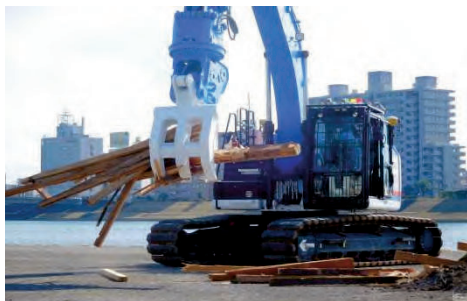
遠隔操作によるガレキ等撤去
