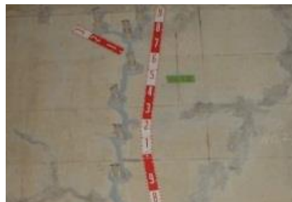
補修状況(ひび割れ補修)
