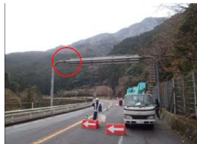
補修状況(ボルト取付)
