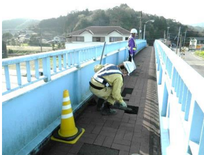
補修状況(タイル補修)
