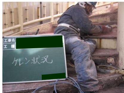
補修状況(鋼材防食塗装)
