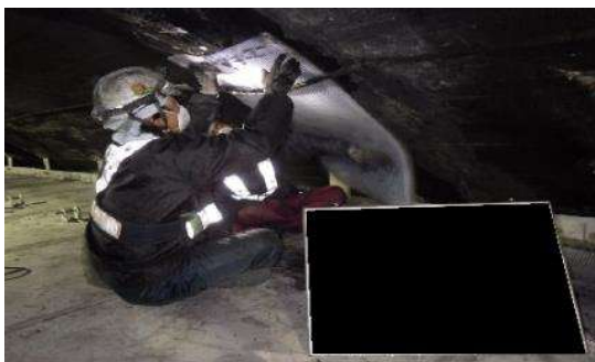
漏水防止シート取付
