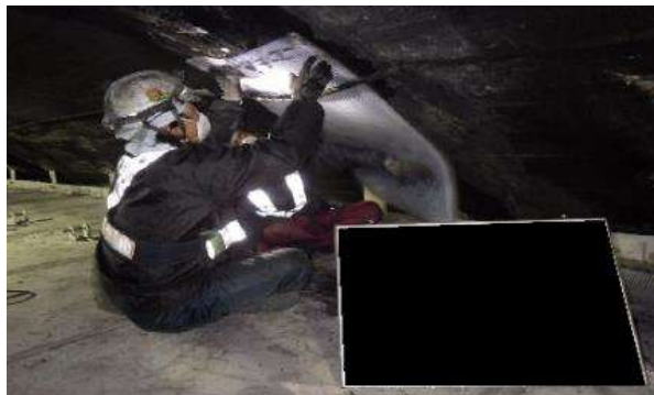
漏水防止シート取付
