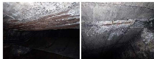
床版下面の鉄筋露出
