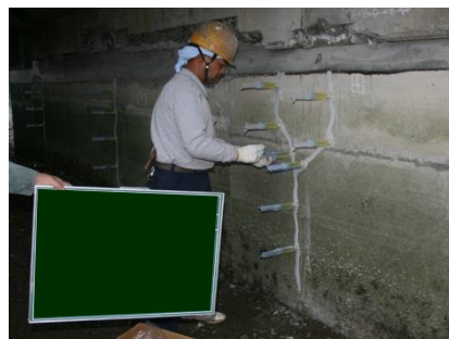
補修状況(ひび割れ注入)
