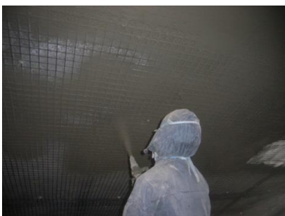
補修状況(断面修復)
