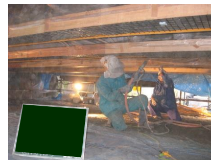
補修状況(断面修復)
