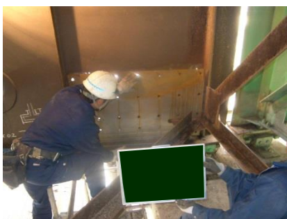
補修状況(当て板補修)
