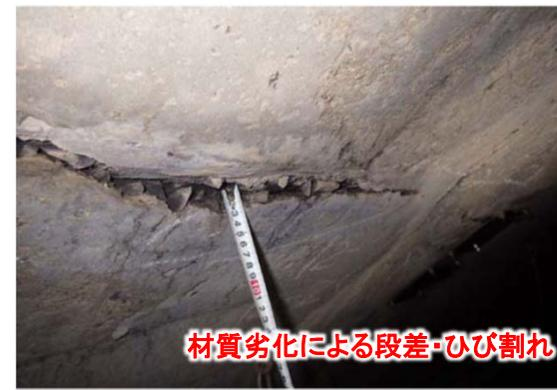
▲既設トンネルの損傷状況 (H28点検)
