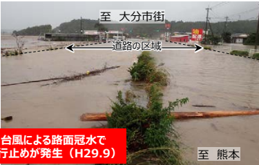
▲台風による国道10号の冠水被害(上戸次付近)
