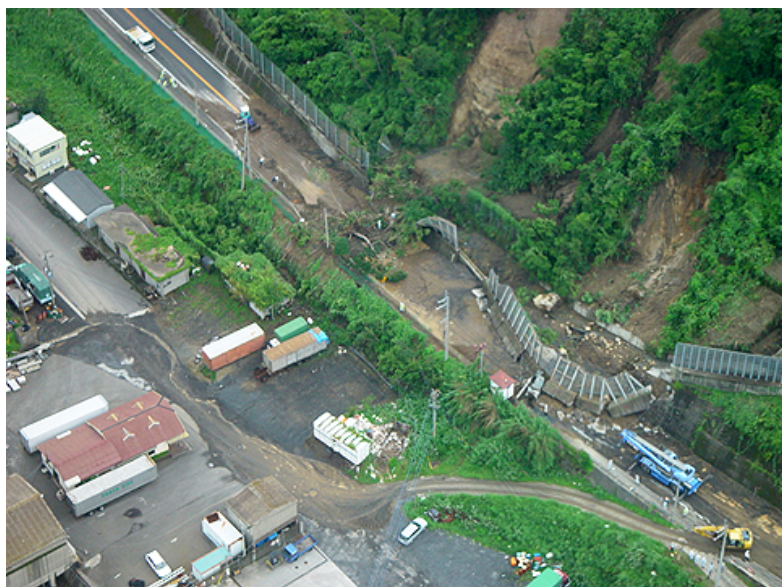
■一般国道220号（鹿児島県垂水市）の復旧状況
