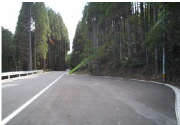
■1.5車線の道路整備 (1車線改良+待避所設置)
