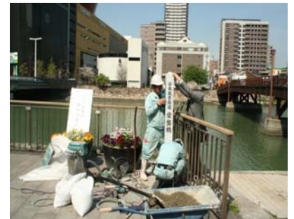
・ルート標柱設置 (常盤橋)
