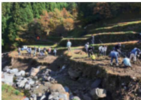
復旧作業状況
