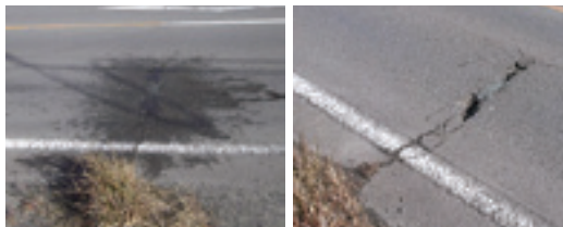
報告から4時間で修理完了 投稿された道路の危険箇所
