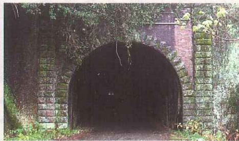
側壁が垂直の佐敷隧道
