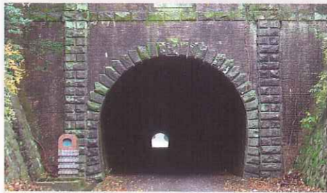
坑口が馬蹄形の津奈木隧道
