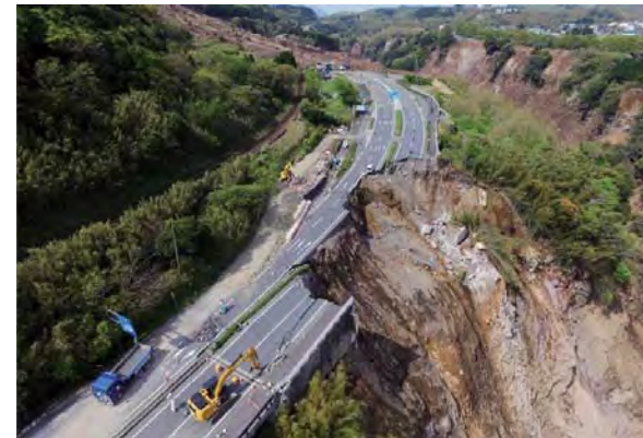
大きく崩れた国道57号
