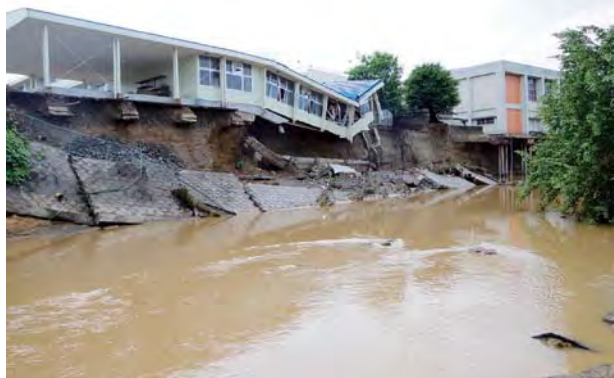
朝倉市宮野 比良松中学校 桂川 護岸被災 中学校も被災
