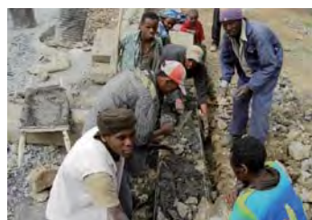
写真1 完成間近の現場の様子
