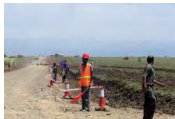
写真4 現場における交通整理員
