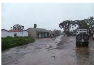
写真5 雨期になると濁流と化す道路
