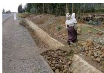
写真3 完成時の側溝の写真
