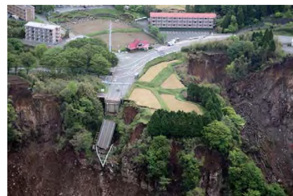
崩落した阿蘇大橋
