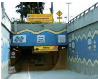
トンネル入り口。中央のシンボルマークが構造をあらわしています
