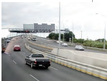
オークランド：コンクリートブロックの中央分離帯が朝夕で移動
