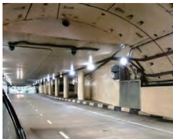
トンネル最上層の導水ゲート部分
