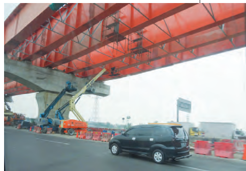
既設の高速道路の上に、さらに高架高速道路を建設中
