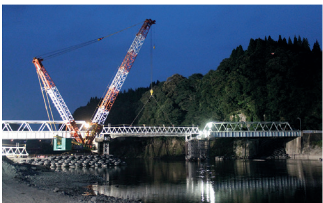
人吉市 西瀬橋 仮橋設置工事 (8月21日)
