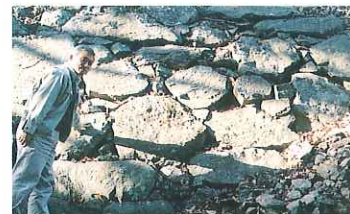
本丸東面の石垣。天守台と異なり、割った石と自然石の両方を用いた野面積みで、城内で多くみられる積み方である
