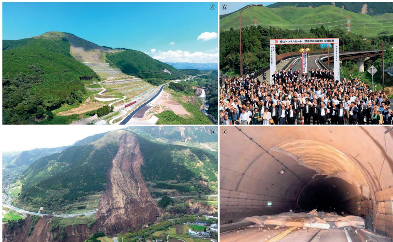
④開通した国道57号。崩壊した斜面に2本の「えん堤」などが築堤されている(中央に電車) ⑤旧阿蘇大橋付近で発生した大規模な斜面崩壊
