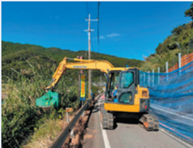
飛散防止ネットの設置
