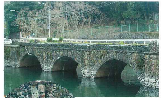
中河内橋 拡幅され湖面側は建設時の石橋だが、山側はコンクリート橋。
