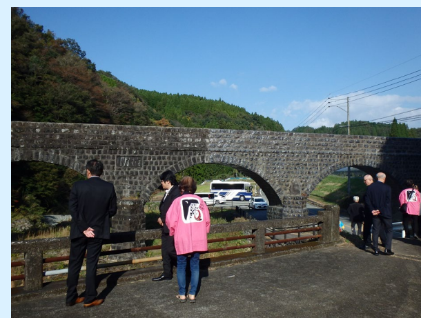
明正井路一号幹線一号橋
