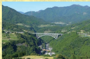
日之影町の名橋「青雲橋」谷を渡るトラスアーチの橋は、まるで空に架かっているような壮麗な眺めです
