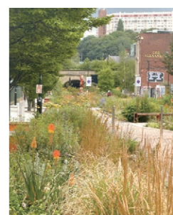
Sheffield (写真4) 植樹帯を雨庭とし宿根草植栽した
