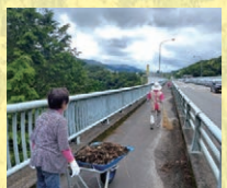
青雲橋歩道部の泥上げ・草引き
