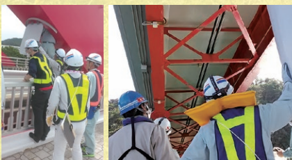
道守養成ユニットによる重点管理橋梁の点検
