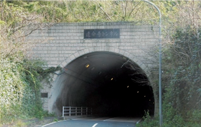
奈留島の遠命寺トンネル
