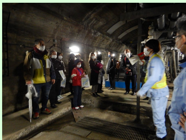
排水設備（地下）
