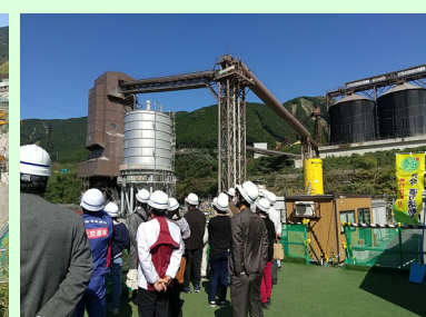
立野ダムプラント
