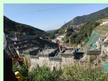
施工中の立野ダム
