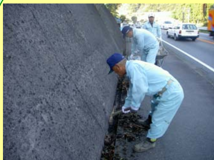
溝にたまった枯葉や土を除去しました
