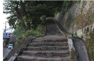
石段155段 除草後
