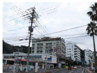
電線共同溝工事現場へ案内
