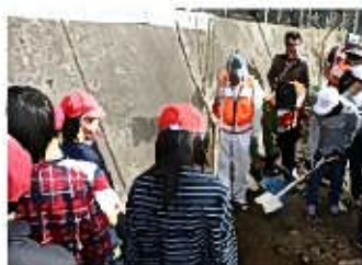
掘った土を埋め戻す
