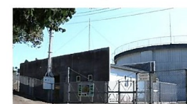
ファームボンド (配水池)
