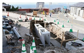
工事中のバス停と歩道
