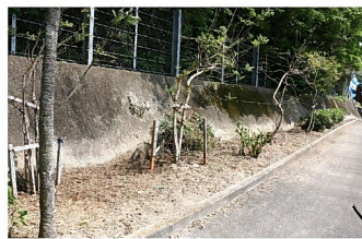
国道57号赤崎緑地帯 除草 5月6日
