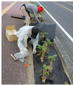
防草シート張り
