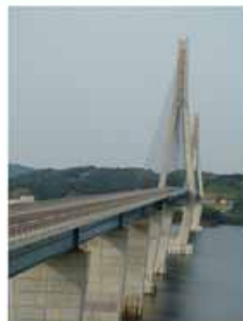
【鷹島肥前大橋】
