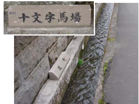
側溝の縁などに設置
