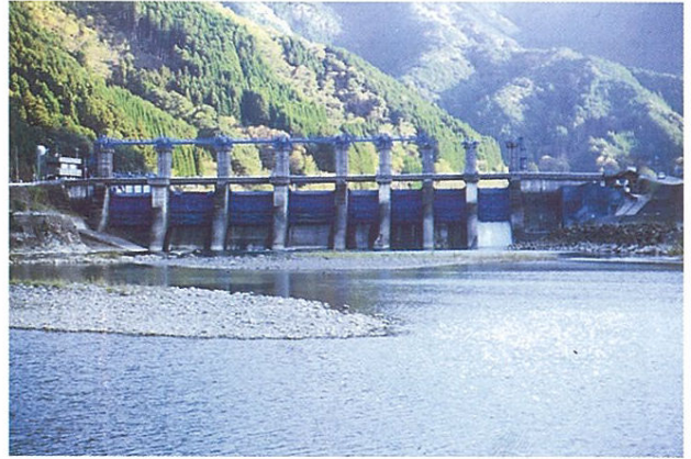
荒瀬ダム（下流側）
