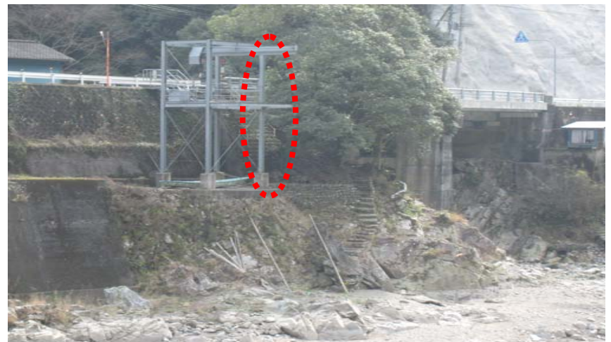
●24条許可:渡し船吊り上げ機(湛水区間)
