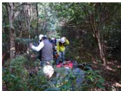
【 遊歩道整備作業の状況】
