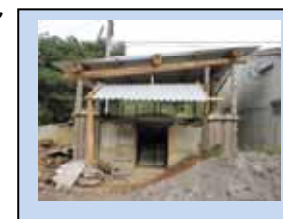
【完成した炭焼き窯】
