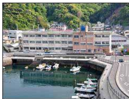
【廃校となった中学校の全景】
