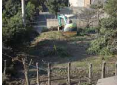
根の除去作業
