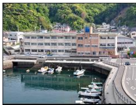
【廃校となった中学校の全景】
