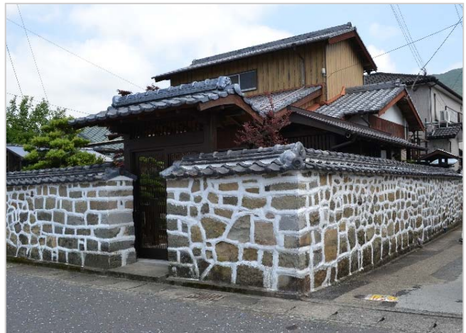
「景観重要建造物・山崎氏石塀」は、角地に立ち、武家屋敷深堀の街角景観を形成している。
