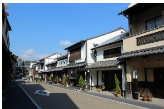
電線類無電柱化を実施した通り
