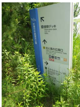
図－5.4.7 サインの基礎部に繁茂する草でサインが見えづらくなっている例
