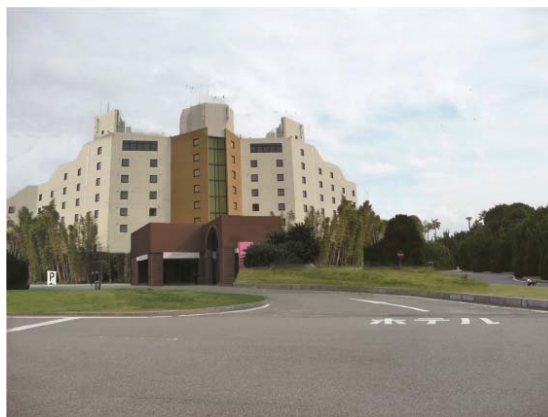
新たにサインを設置せずとも、ホテルの入口、ホテル駐車場の入口が容易に確認できる。
