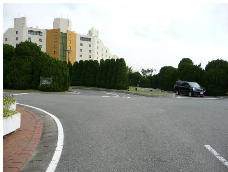
現在の状況（植栽によりホテル入口やサインが認識できない。）
