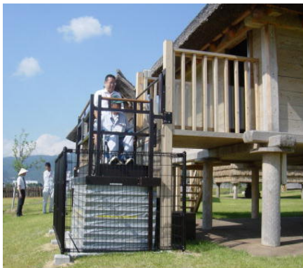
＜車いす昇降装置＞
