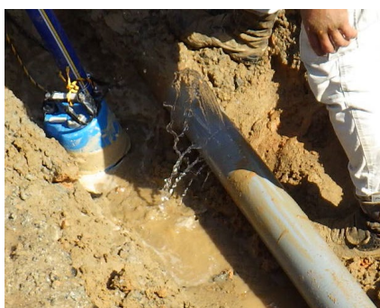
老朽化した上水管
